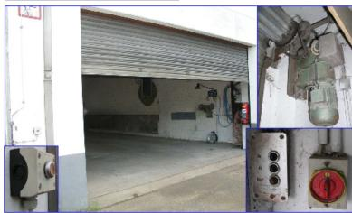
Die verbindungsprogrammierte Steuerung (Schütz-Steuerung) des Hallentors ist defekt und soll durch eine moderne Speicher-programmierbare Steuerung ersetzt werden.
