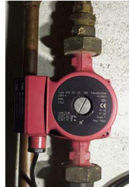
**In diesem Rahmen beauftragt sie oder er ein Installationsunternehmen mit der Überprüfung, ob der Austausch der verbauten Heizungsumwälzpumpe gegen eine moderne Hocheffizienzpumpe möglich ist.**
